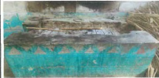
FOTO 6: Polletón y chimenea existentes en la cocina del establecimiento los cuales debido a su uso, presentan daños notorios en su estructura.
