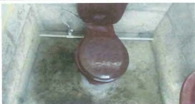
FOTO 11: Inodoro deteriorado en su tubo de abasto, contra llave y tanque lo cual impide actualmente su utilización.
